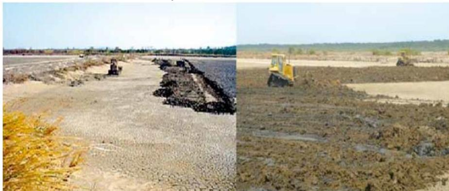
*Labores de eliminación de sedimentos y restablecimientos de canales de cosecha del fondo de estanques camaroneos; así como conformación de los muros. (Fotografía tomada de J.Cuellar-Angel et. al., 2010).*
